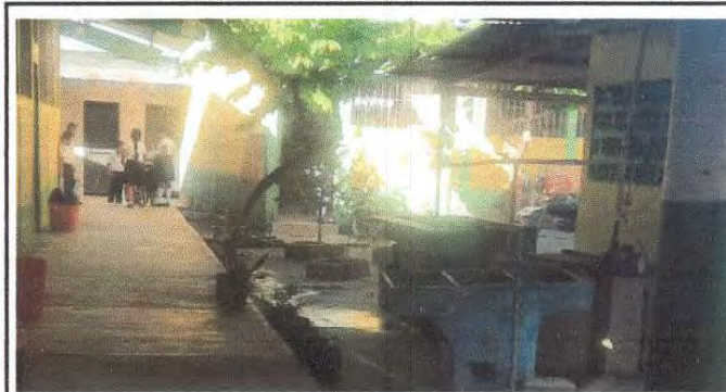
Foto 3: Proceso de cambio de piso de cemento liquido.
