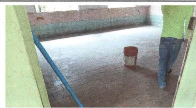
Foto 4: Proceso de cambio de piso de cemento liquido.
