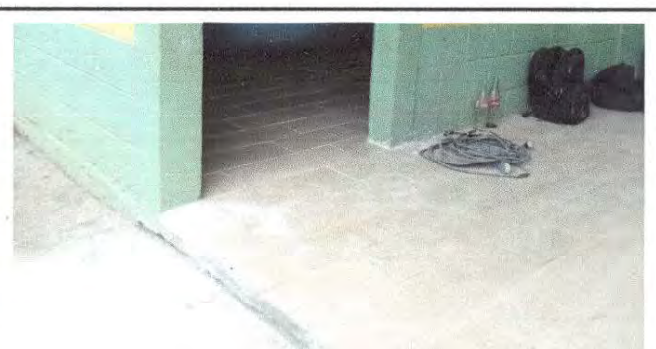
Foto 6: Proceso de cambio de piso de cemento liquido.
