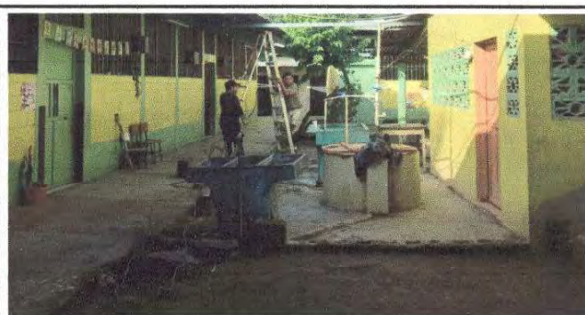
Foto 6: Proceso de sustitucion de estructura de metal
