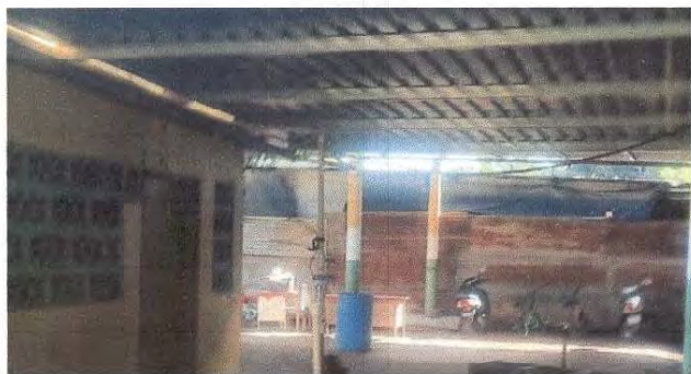
Foto 1: Proceso de sustitución de lamina acanalada calibre 26
