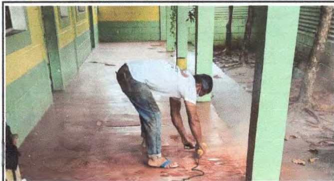
Foto1: Proceso de cambio de piso de cemento liquido.
