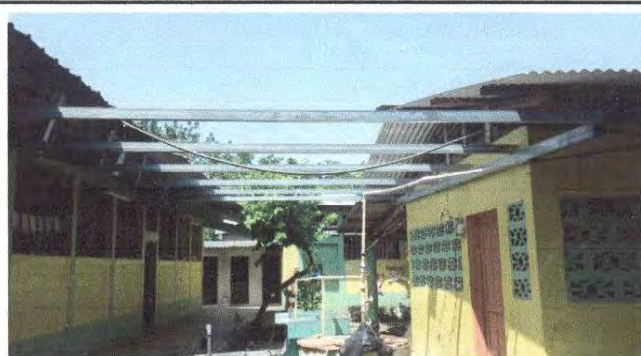
Foto 4: Proceso de sustitucion de estructura de metal
