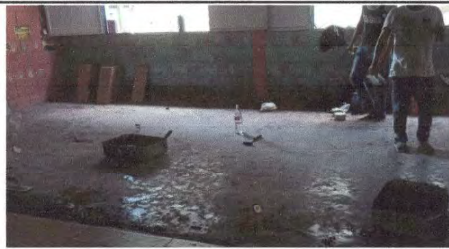
Foto 2: Proceso de cambio de piso de cemento liquido.
