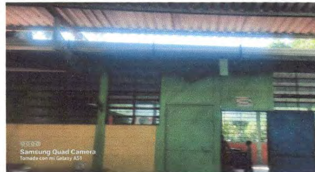
Foto 2: Proceso de sustitución de lamina acanalada calibre 26
