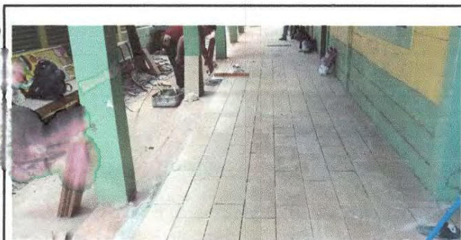
Foto 5: Proceso de cambio de piso de cemento liquido.
